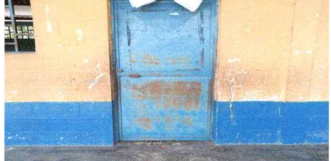
Foto 14: Mantenimiento a estructura lijado aplicación de pintura
