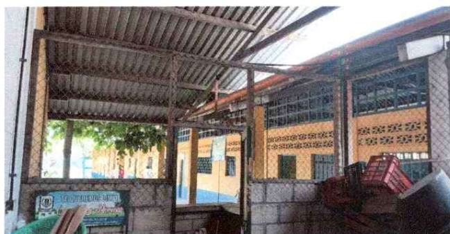
Foto 3: sustitución de ventana de madera con malla por metal
