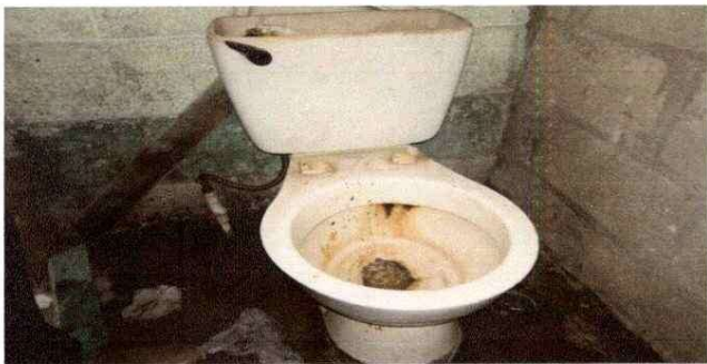
Foto 9: Sustitucion de inodoros
