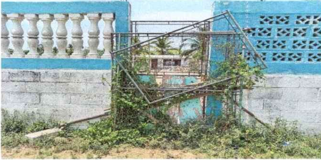
Foto13: Sustrucion de porton de metal
