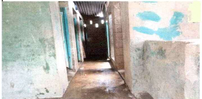
Foto10: Sustitucion de puertas de inodoro de madera por metal
