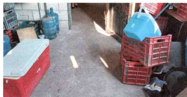
Foto 4: Sustrucción de piso rustico por piso cerámico
