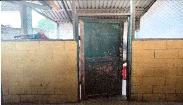
Foto 7: sustitucion de puerta de madera por metal
